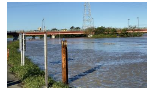
▲令和元年 10 月台風第 19 号時の荒川増水の様子
